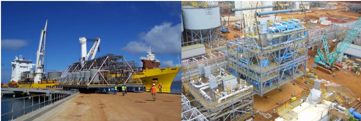
Déchargement et mise en place des modules pour l'usine commerciale, 2006
